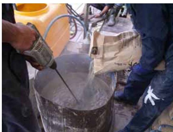
ハンドミキサーによる 充填材攪拌状況
