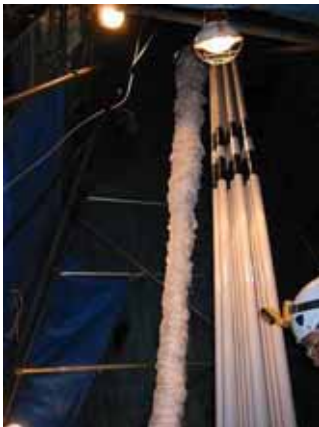
ガイド管の2本繋ぎと蛇腹状のパッカー
