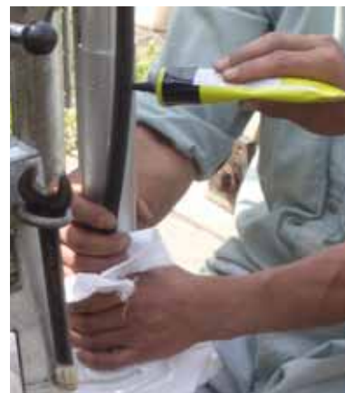
コーキング材の塗布状況
