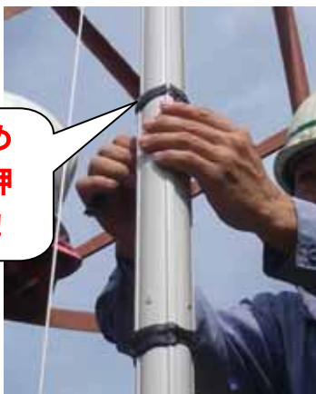
止水材の巻きつけ状況
