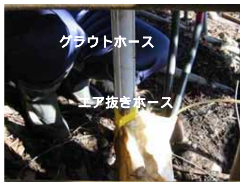
ガイド管挿入後の孔口の状況
