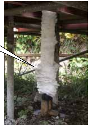
塩ビ管に被せたパッカーの孔口取り付け状況
