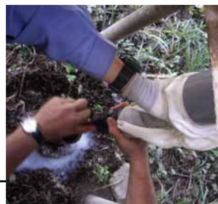
ガイド管の下端は、挿入開始時にテープで固定する(忘れないように)
