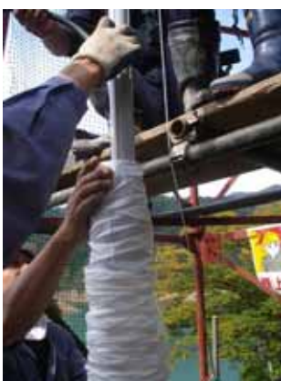
ガイド管の挿入状況
