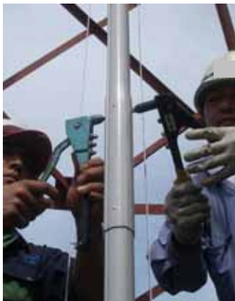
リベットの打設状況
