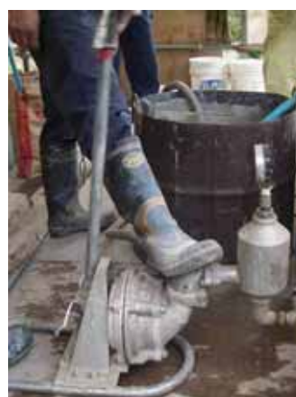
手押しポンプによる 充填材の注入状況
